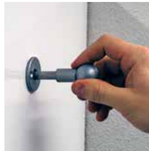
Hormin sulkupelti avataan
