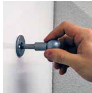
Hormin sulkupelti avataan
